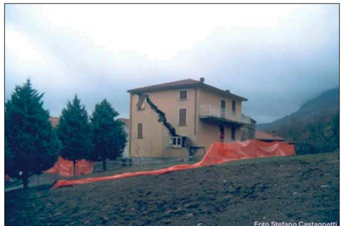
Foto 9 - Frana di Tosca di Varsi (PR). La casa sorge sul limite destro del corpo di frana e il coinvolgimento di uno spigolo dell'edificio ne ha prodotto l'evidente dissesto. Sul retro del fabbricato sorge una casa a torre risalente ad alcuni secoli orsono, a testimonianza della stabilità del sito, nonostante il movimento franoso risulti documentato a partire da fine 1800 (foto scattata da Stefano Castagnetti).
