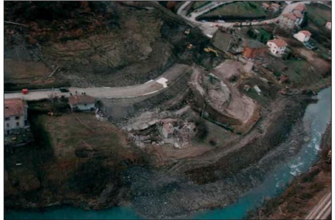
Foto 2 - Frana di Marano. Primi interventi di emergenza per il ripristino della viabilità, delle reti di servizio (gas e acqua), e per limitare l'occlusione dell'alveo del Fiume Reno (foto Pelagalli per conto del Comune di Gaggio Montano).
